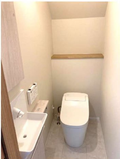
階段下のトイレ (1か所)
